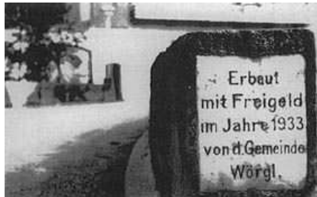
Abb. 1: Brücke erbaut mit Freigeld
